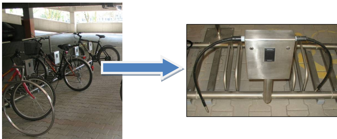
Fot. 1.1. Przykład ramy z wbudowanym zapięciem na terenie parkingu kubaturowego P+R Młociny
