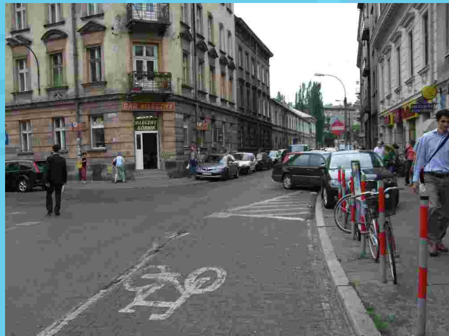
Oznakowanie poziome na ul. Dolnych Młynów wymagające odnowienia
